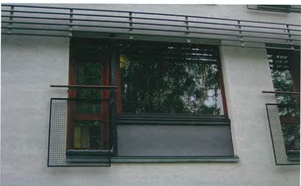
プロラティラホーム／各個室の窓。大きなFIXと内開き窓で二重窓になっていた。この窓形状は市内でもよく見かけた。
